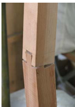
写真1. 欠陥2の長柱の座屈
